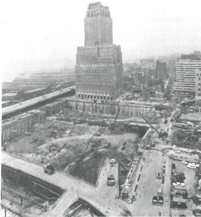
Abb. 1: Anwendung des von Ch. Veder entwickelten „Schlitzwandverfahren“ beim Bau des New York World Trade Center.
