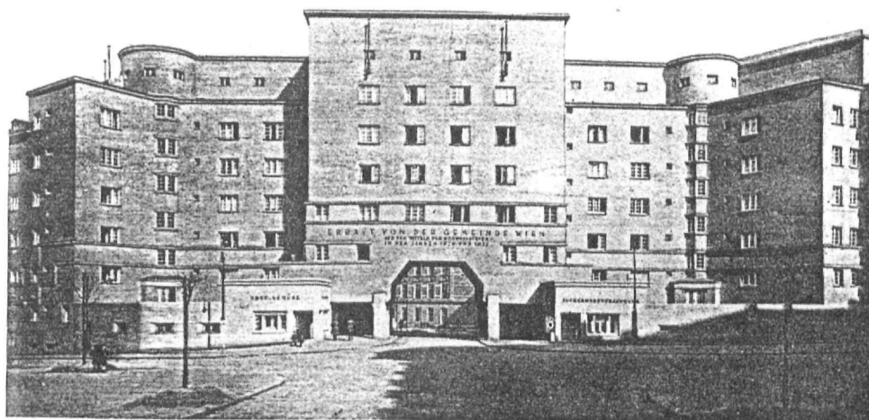
„Matteotthof“, erbaut 1926, Architekten Schmid und Aichinger
